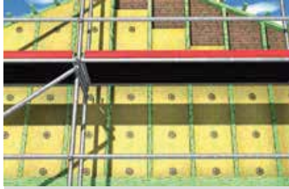
Dämmstoffe in hinterlüfteten Fassaden
