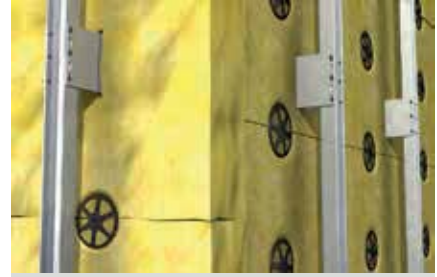
Dämmstoffe in hinterlüfteten Fassaden
