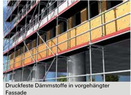
Druckfeste Dämmstoffe in vorgehängter Fassade
