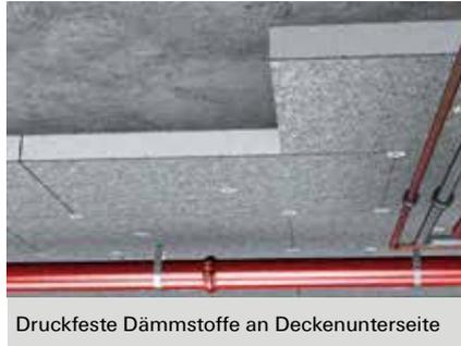
Druckfeste Dämmstoffe an Deckenunterseite
